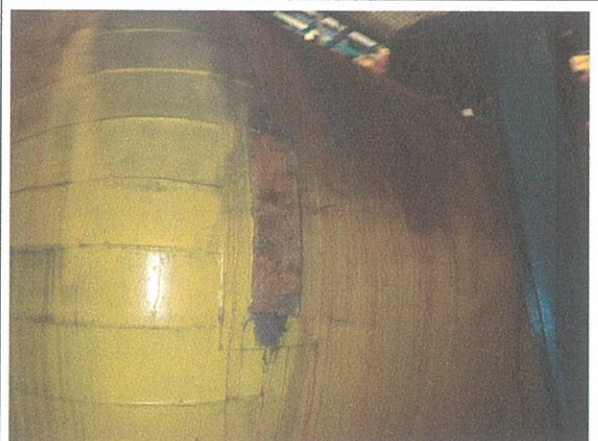
รูปภาพที่ 6 ชื่อเรื่อง ถังบรรจุคลอรีนเหลว หมายเลข Tag no. TK-552
